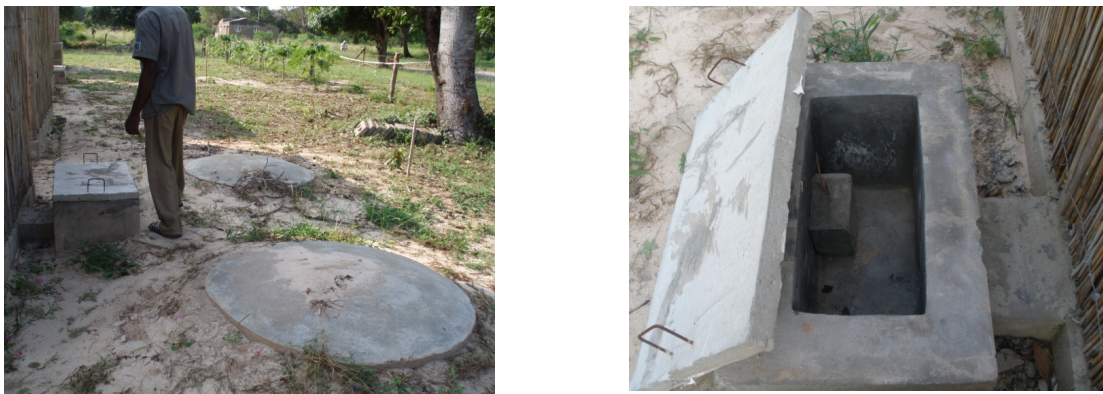
Figura 3.7 Latrina de compostagem (fotografias tiradas em Maio de 2010, em Moçambique)
